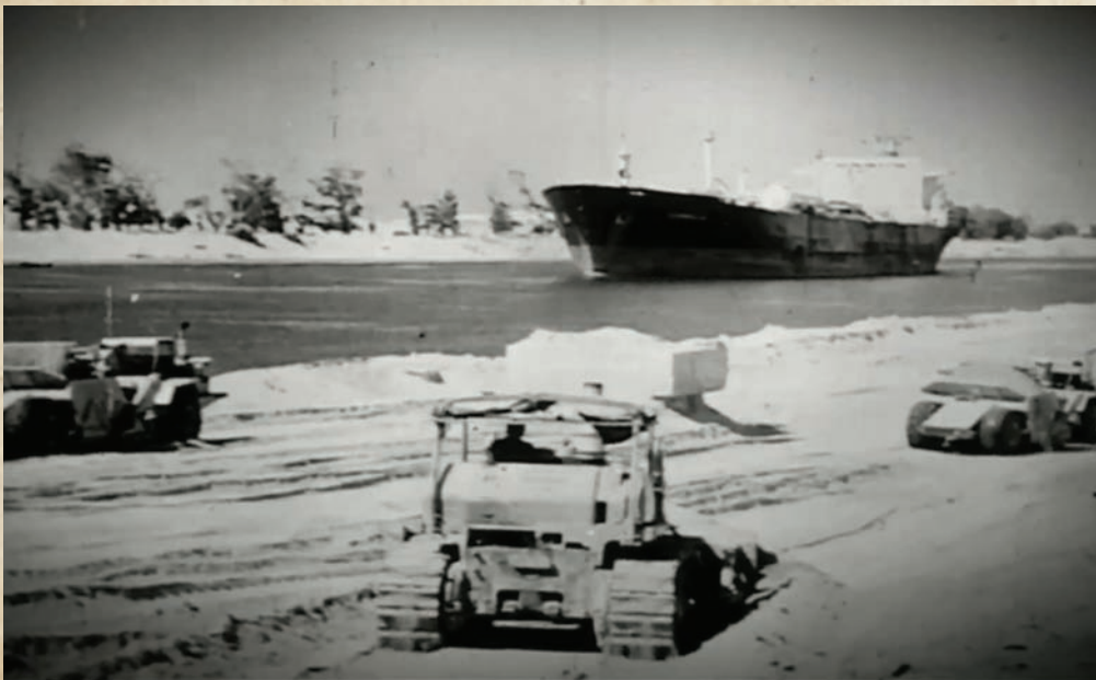
أعمال تطوير القناة
